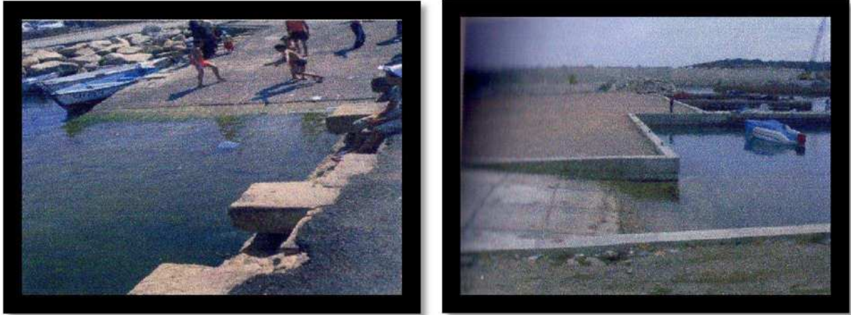
Figure V.6 : Cales de halage dans le port de Tipaza
