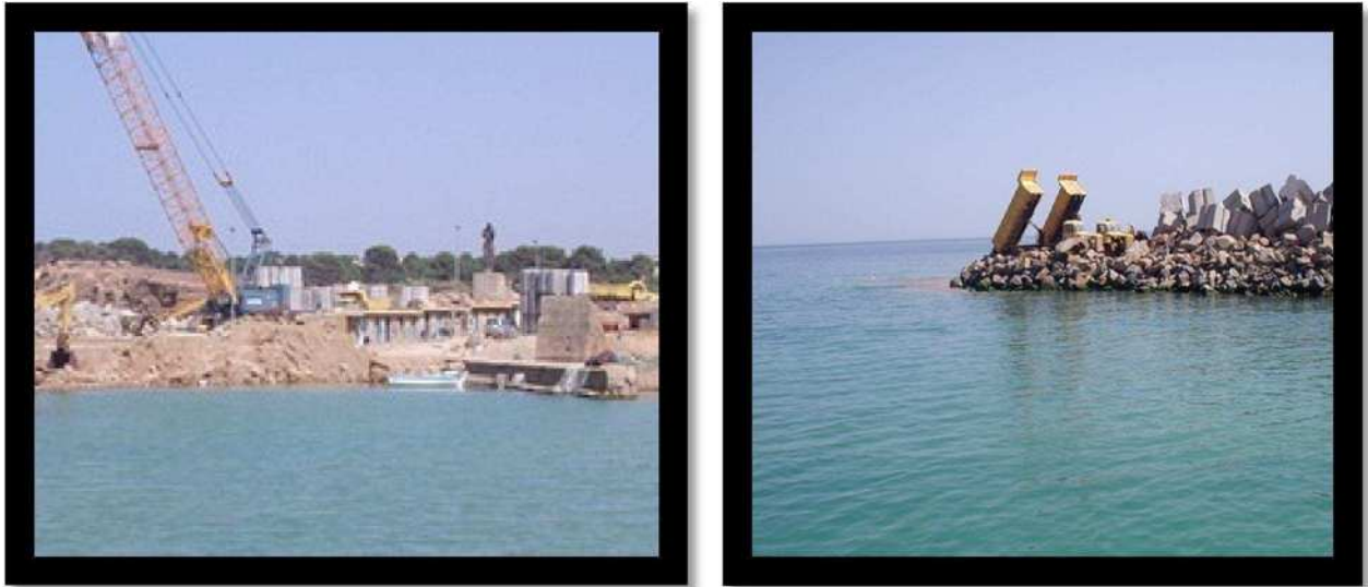
Figure V.12 : Opération de dragage du port de Tipaza 2008.
