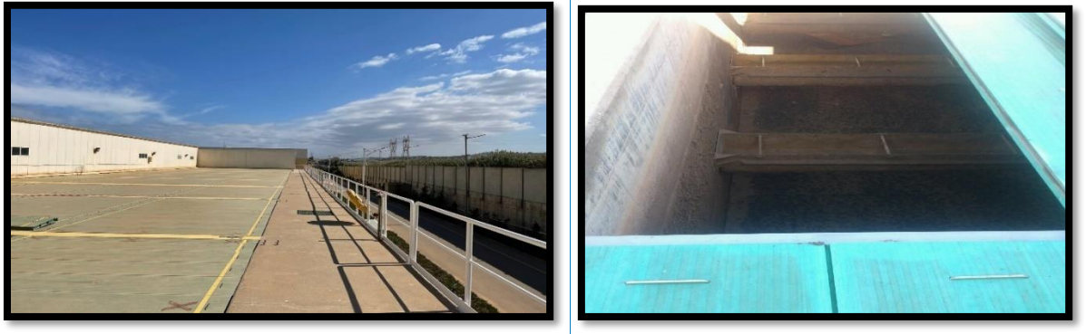
Figure III.15: Filtres à sable. (Source : Loutis Dehia, Hacheb Hayet ;2023).
