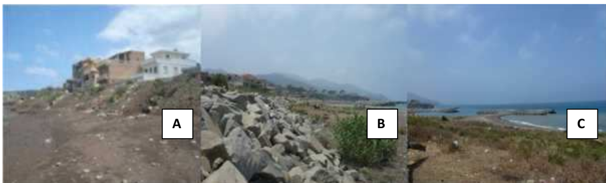
Figure10: les constructions au niveau de la plage Bois sacré : A : habitation, B : mur en enrochement, C : brise-lame
