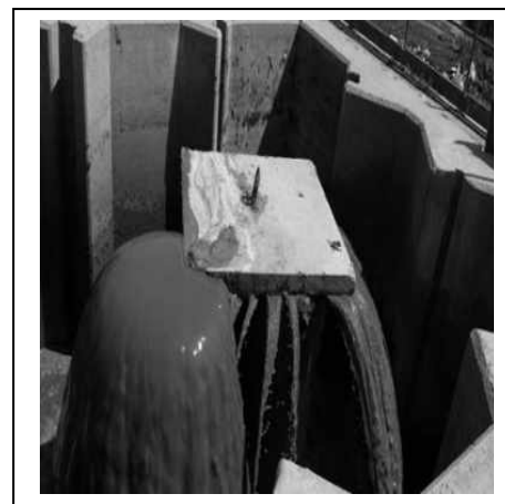
Figure III.9 : L'épaississeur, l'arrivé de la boue
