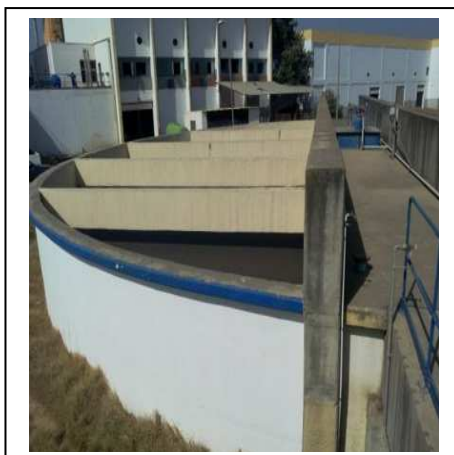
Figure III.9 : L'épaississeur, l'arrivé de la boue
