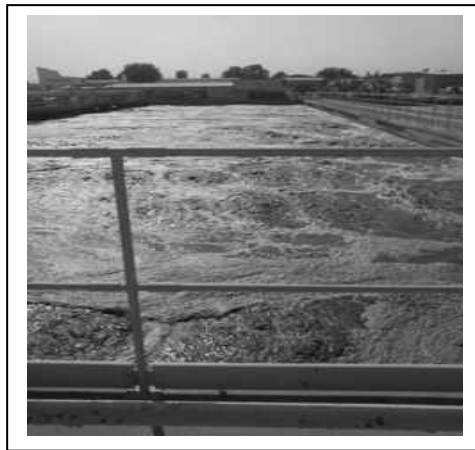
Figure III.7 : Bassin d'aération
