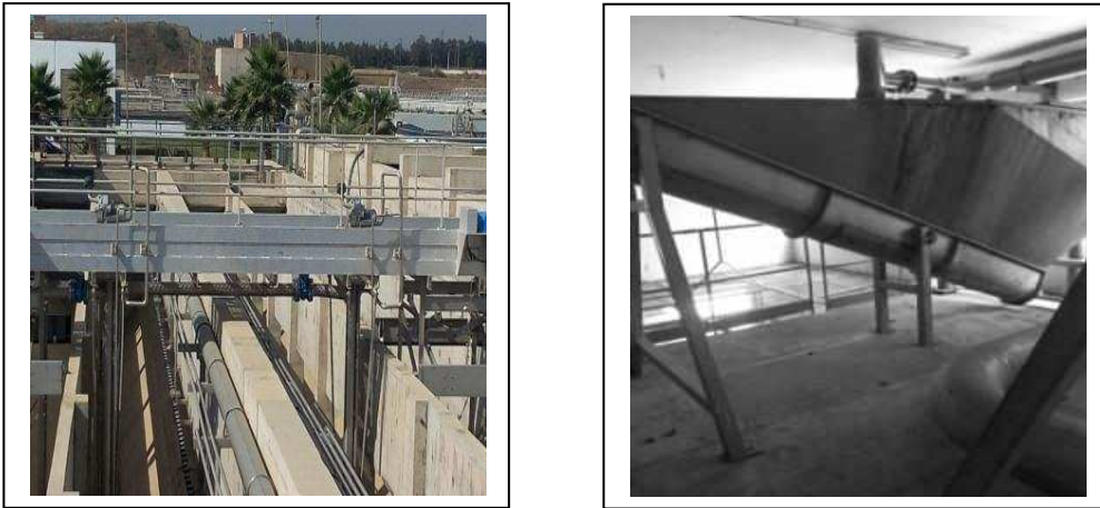
Figure III.6 : Pont racleur, classificateur à sable
