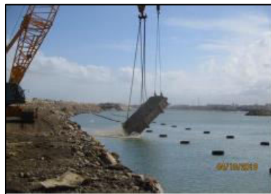
Photo VIII-11 : Remblai du talus de quai.
