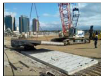
Photo 9 : Mise en stocks des blocs
