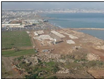
Photo VIII-3: Aire de stockage des prédalles, blocs de Cubipodes et de quai.
