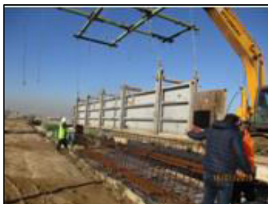
Photo 06 : Coffrage de la poutre
