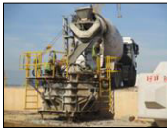
Photo 03: Préfabrication des blocs 3T/12T
