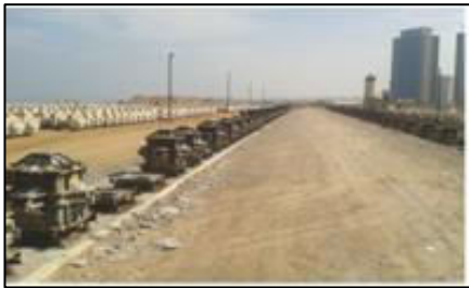
Photo 01: Plate-forme de coffrage.
