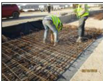
Photo 010 : Assemblage de coffrage métallique.
