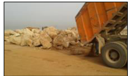
Photo VIII-1 : Fourniture de TVC et d'enrochements.
