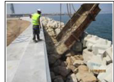
Photo VIII-8 : Clavage de couche filtre.
