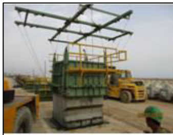
Photo 05: Démoulage des blocs.
