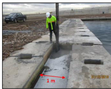
Photo VIII-13 : Bétonnage des vides
