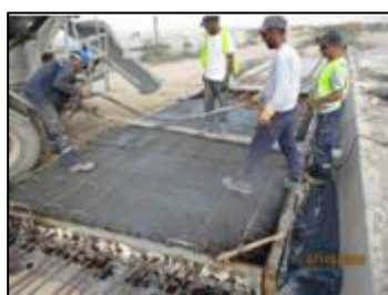
Photo 08: Bétonnage des dalles.
