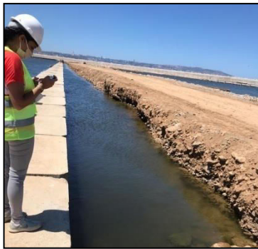
Photo VIII-15 : Pose des blocs de quai
