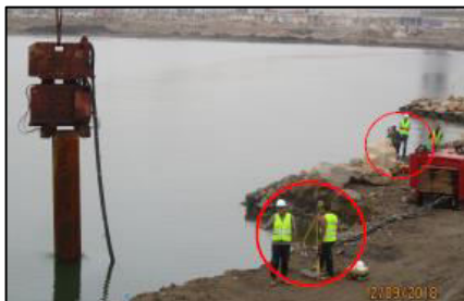
Photo VIII-12 : Vibrofonçage des pieux.
