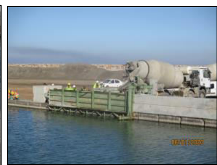
Photo VIII-14 : construction de la poutre d'accostage
