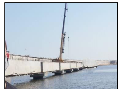
Photo VIII-10 : Pose des prédalles.
