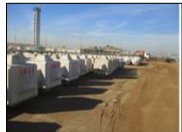
Photo 02: Zone de stockage des blocs 12T
