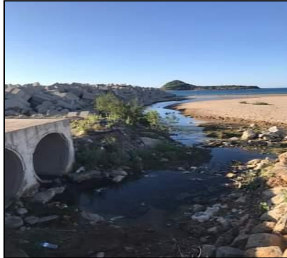
Photo 15: Déversement d'eaux usées au niveau de la plage Grand îlot –El Aouana-
