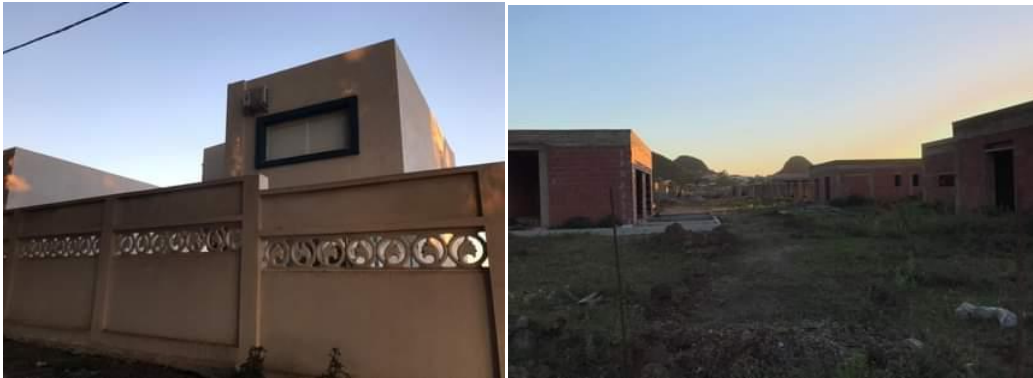
Photo 23: Nouvelles constructions touristiques côtières.
