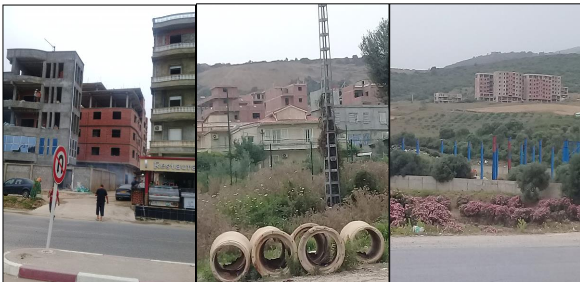
Photo 19 : Nouvelles constructions au niveau de la zone d'étude.
