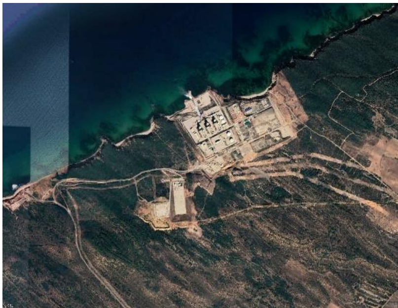
Figure 3. 18: Centre d'électricité Kodyet El-Draouche commune de Berihanne ( source google earth )
