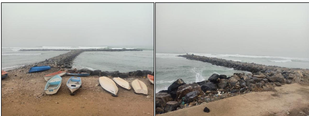
Figure 44: Ouvrages de protection du front de mer de Bou-Ismail, 2020.
