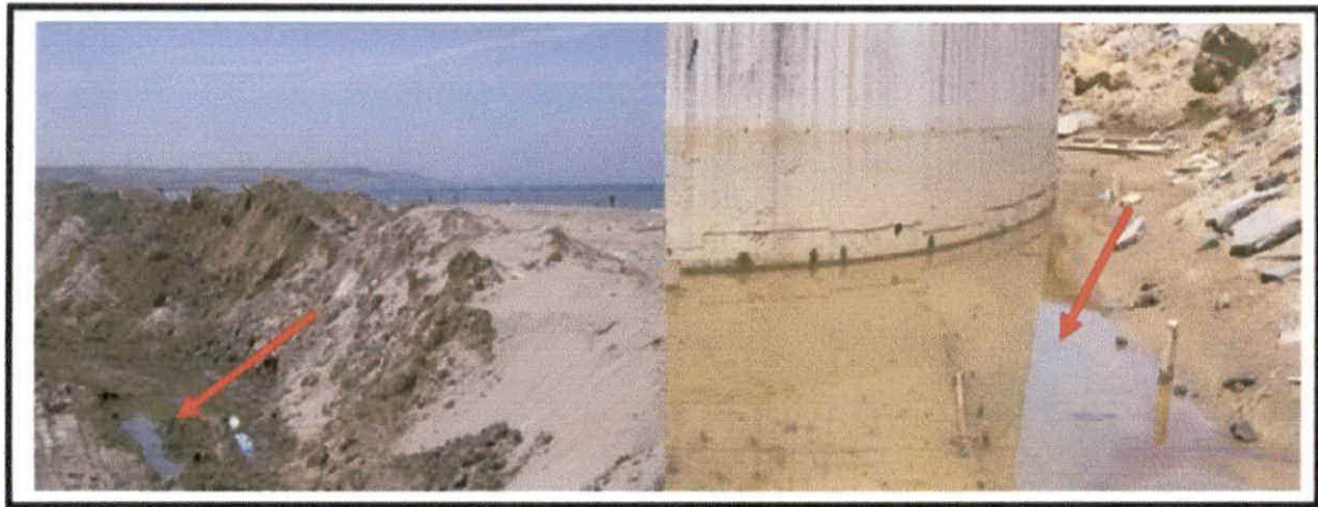
Photo n°7 : Sol de fondation de nature peu perméable, inondé (hôtel en construction).
