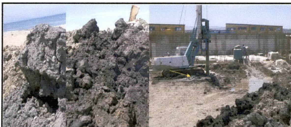
Photo n°6 : Marne de couleur grise extraite à partir de 7m de profondeur lors de forage de pieux.
