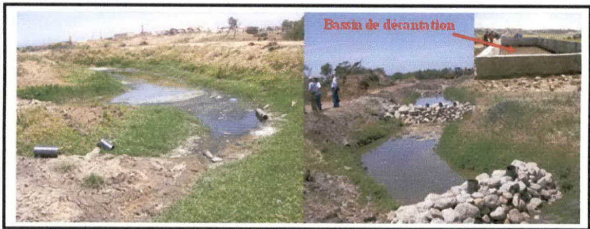
Photo n°10: Système de lagunage naturel.
