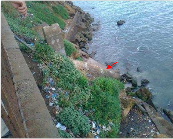
Photo n°1 : Une embouchure d'eau usée dans la zone.
