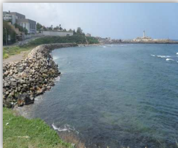
Photo n° 8: Ouvrage de protection -site Est-
