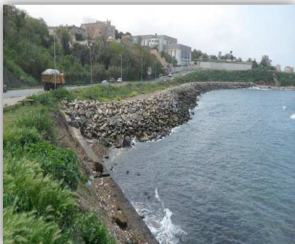
Photo n° 7: Ouvrage de protection -site Est-
