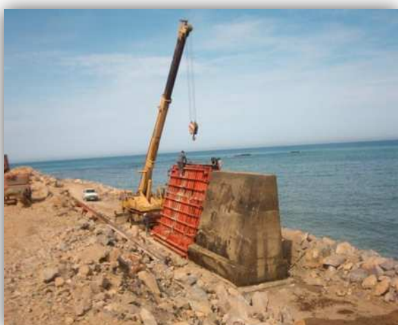
Photo n° 11: Fabrication du mur de soutènement
