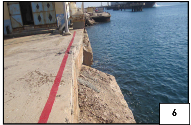
Photo N°5: fissuration et tassement très visible de la dalle de couronnement
