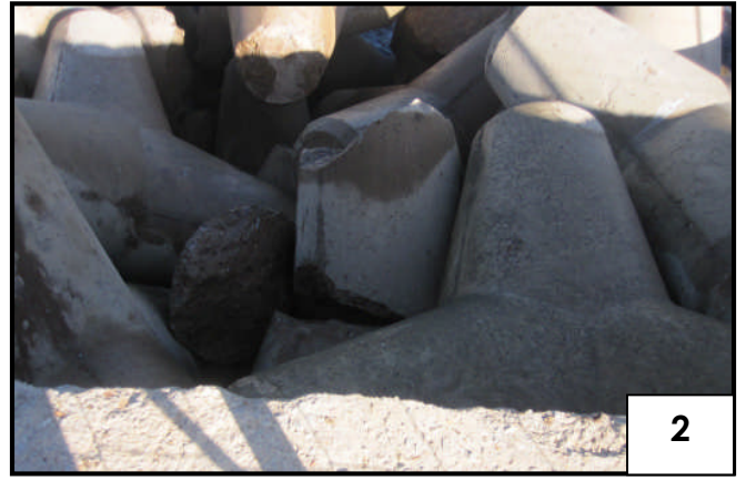
Photo N° 1 : dégarnissage de la carapace coté extérieur vers Musoir Est
