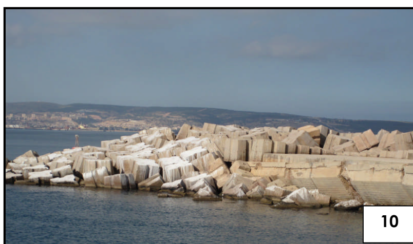
Photo N°10: le musoir Ouest ne s'est pas dégradé depuis sa dernière réparation en 1994 du moins en partie aérienne.
