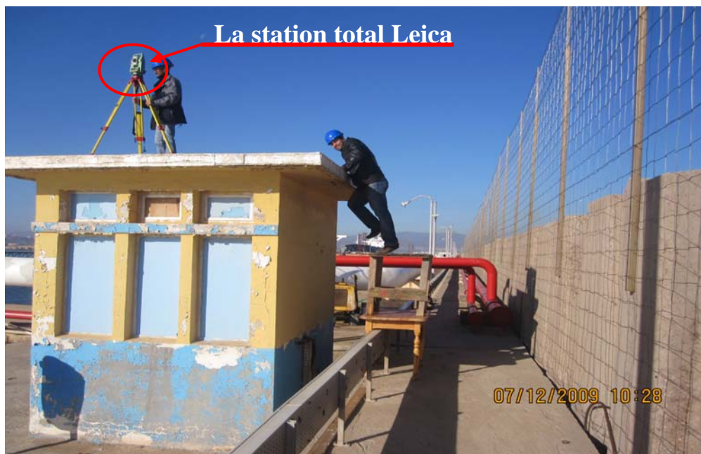
Photo N°1 : l'installation de la station totale Leica (HMI)
