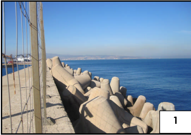
Photo N° 1 : dégarnissage de la carapace coté extérieur vers Musoir Est
