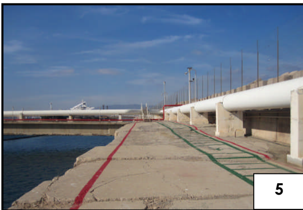
Photo N°5: fissuration et tassement très visible de la dalle de couronnement
