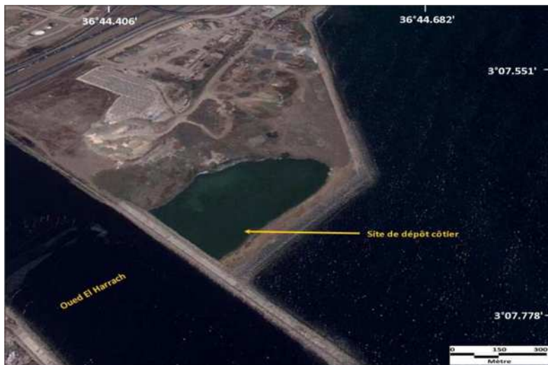
Figure IV.3. Digue d'encloture du site de dépôt côtier des produits de dragage (Oued El Harrach)
