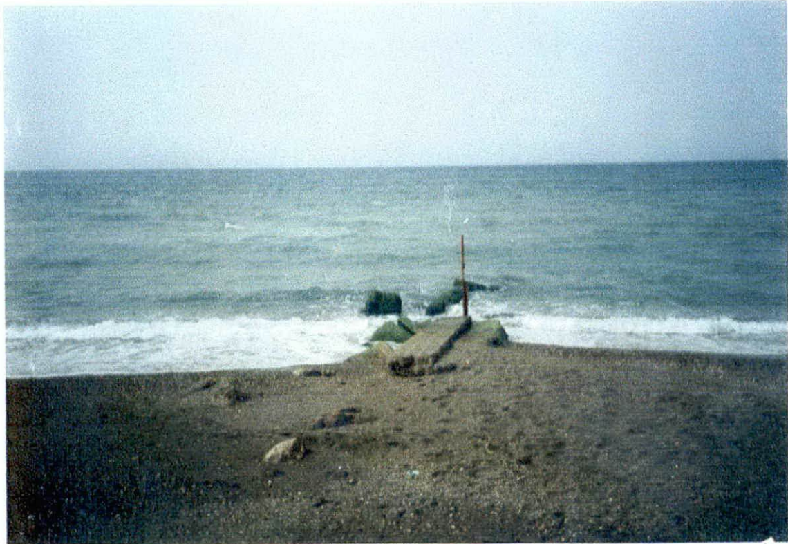
Photo N°3 : Situation d'un épi daté de 1963 - 1964
