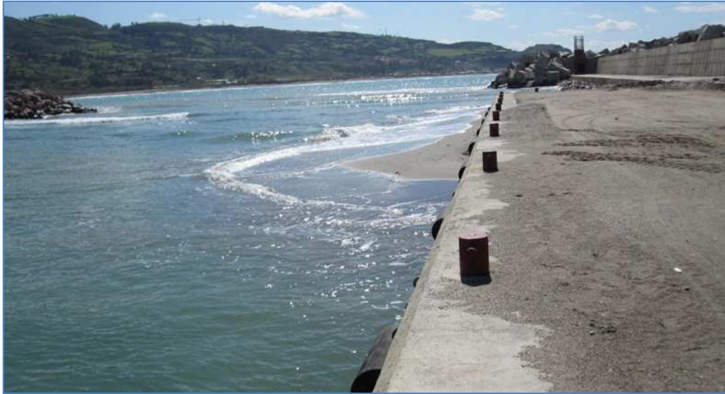
Annexe A.2 : Photos prises lors de notre visite au port de cap Djinet, montrant l'état de son ensablement (2011).
