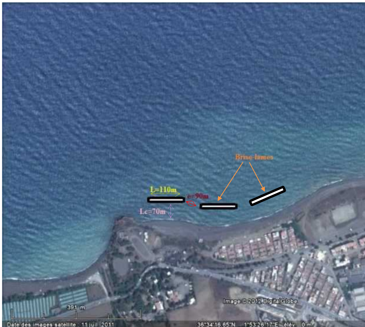
Figure No.35 : Installation des brise-landes sur la zone de Bois Sacré
