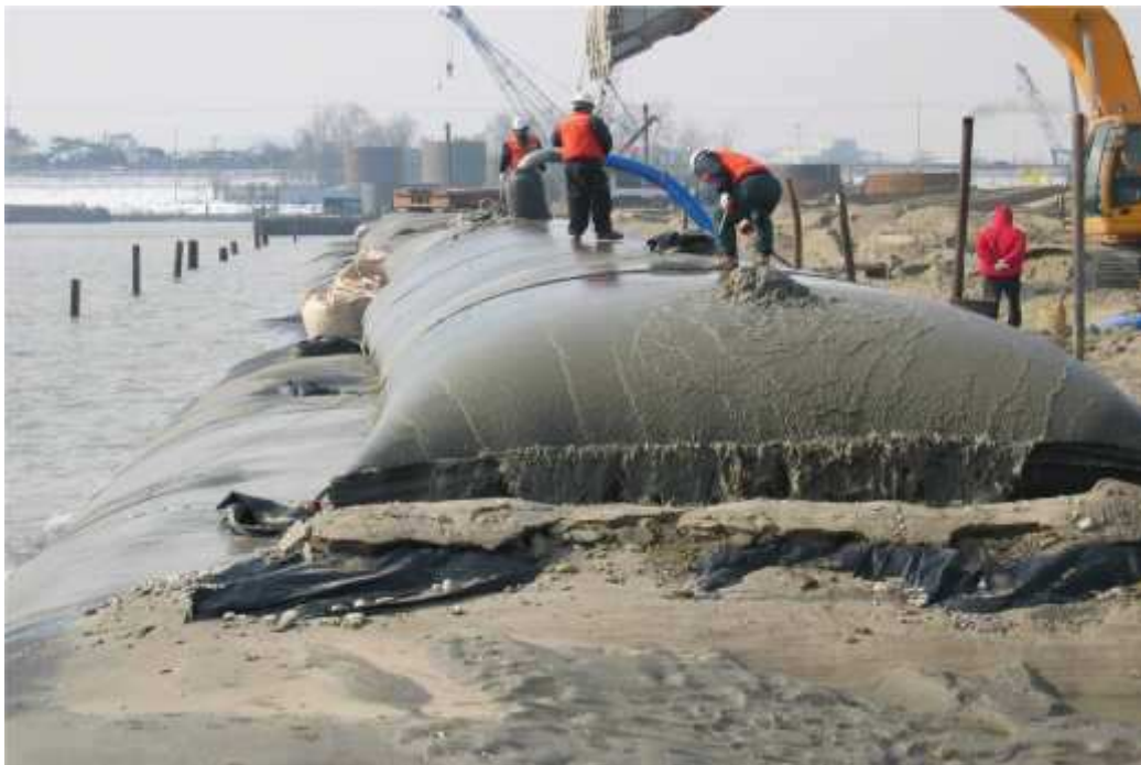
Photo No.06 : Installation d'un géotube.
