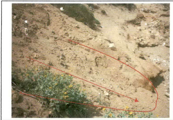
Photo.n°6 : Glissement rationnel simple au niveau de la page "La Fontaine"
