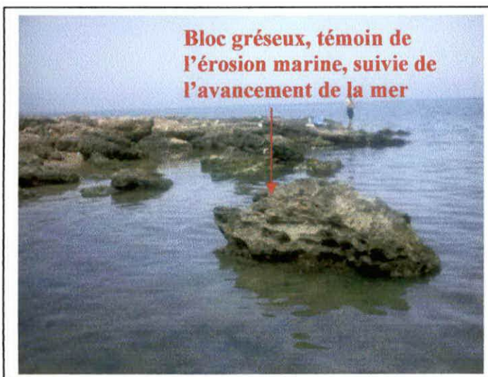
Photo.n°11 : l'action destructive de la houle
