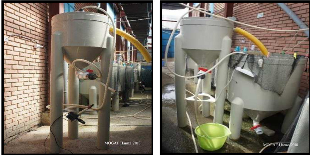
Figure 41 photos du système de décantation 3.
