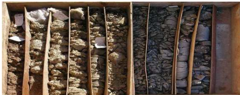
Figure 9 : Photo montrant des marnes du Plaisancien, (Sc10 sur la coupe AA') [JICA, 2006].
