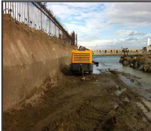
Figure 23: Opération de dragage du port de Sidi-Fredj
