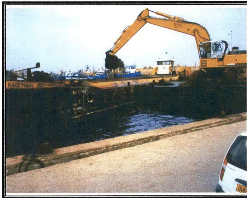
Photo N°2 : L'extraction des matériaux dragués.
