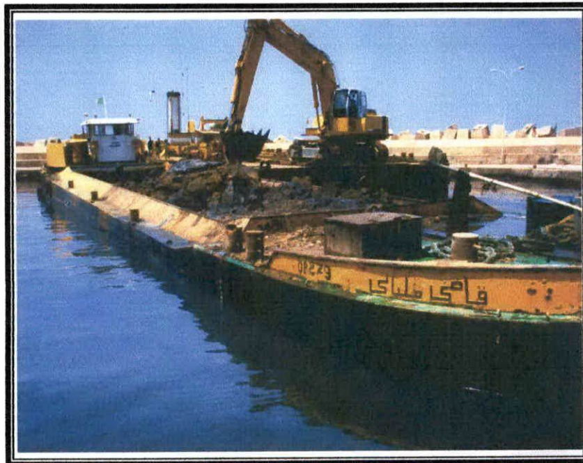
Photo N°3 : Le chaland à clapets KADI MILIANI rempli.
