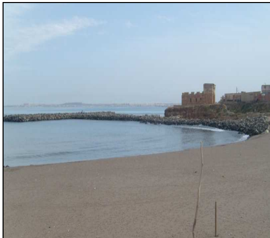
Photo 5 : La protection du fort de Fort de l'eau.
