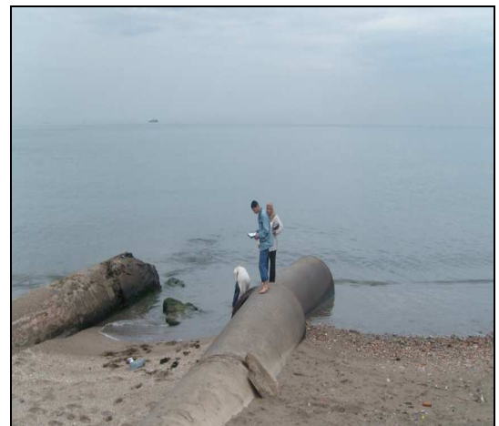
Photo 6: Deux grands rejets des eaux usées.
