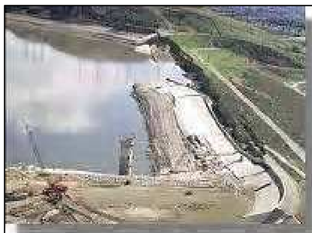
Figure I.1 : effondrement du parement amont de San fernando (Espagne) (Le séisme de 1971)
