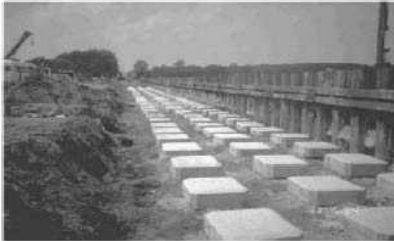
Figure II.1 : vue de chantier de remblai ferroviaire, visualisation des têtes d'inclusion avant l'édification du remblai (2002)
