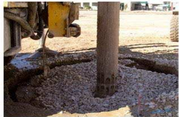
Figure II.4: un cône d'affaissement apparaît autour du vibreur ( Document de Keller® )
