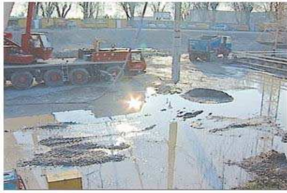
Figure II.3 : Vue d'un chantier de Vibrocompactage ( Document de Keller® )
