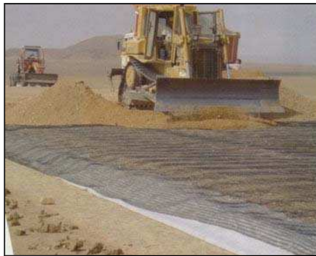
Figure II.6 : vue d'un chantier de réalisation des géosynthétiques.
