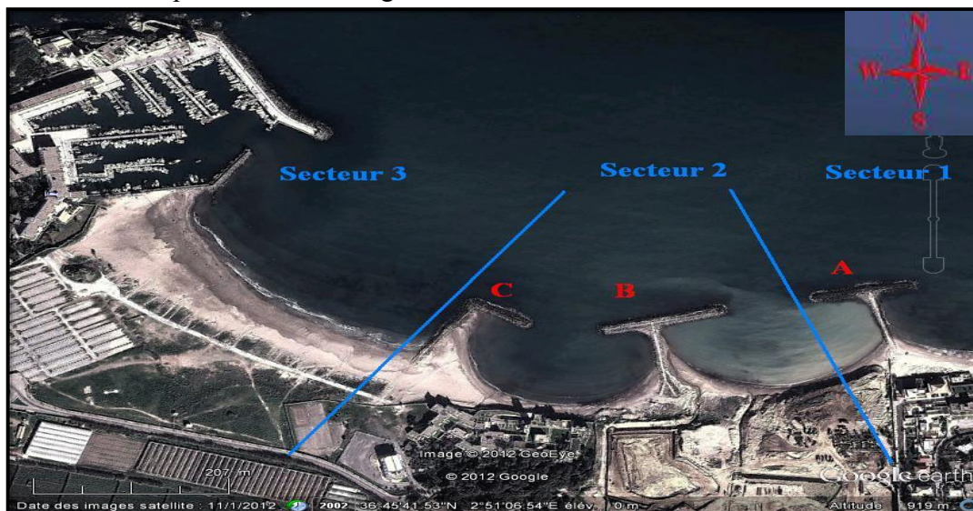
Figure II. 5: Ouvrage de la plage Est de Sidi Fredj (Google Earth, 2012).
