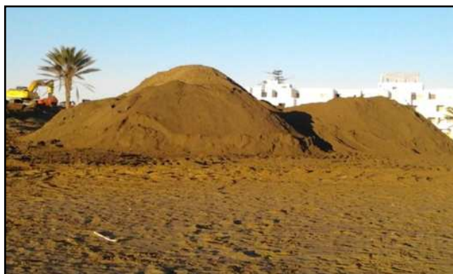
Figure IV.1 : Stockage du sable après dragage au niveau de la plage Est de Sidi Fredj.
