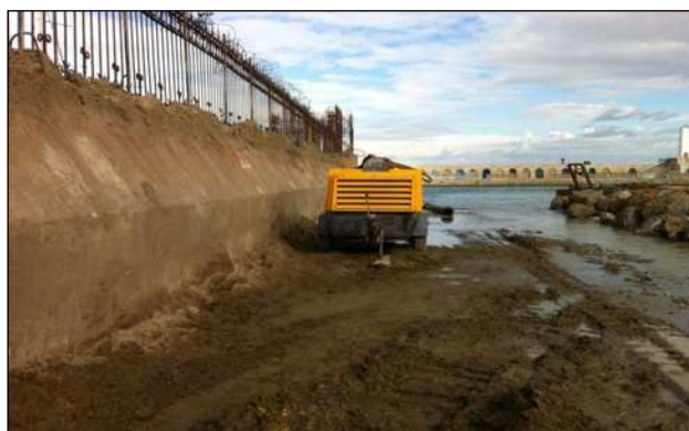
Figure IV.2 : Chenal d'accès (cavalier) pour le dragage de la passe d'entrée du port de Sidi Fredj.
