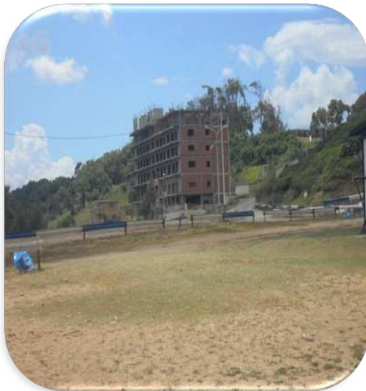
Photo 18 : Hôtel en cours de reconstruction.
