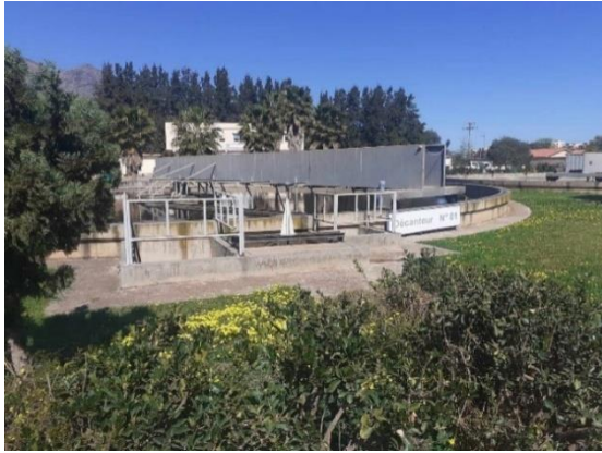
Figure 11: Prélèvement d'eaux usées à partir du décanteur secondaire de la STEP de Chenoua
