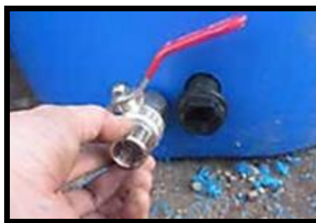
Figure 17 : Installation du robinet de vidange.
