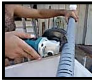
Figure 11 : Percer des fentes de 2 à 3 mm de large sur le tuyau.
