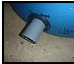
Figure 12 : Insérer dans le trou un tuyau de (50 mm)
