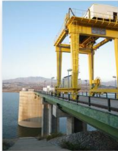
Figure 4. La station de pompage du transfert de Béni Haroun (APW, 2012)
