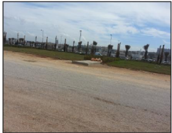
Photo 7 : Achèvement d'une partie des travaux
