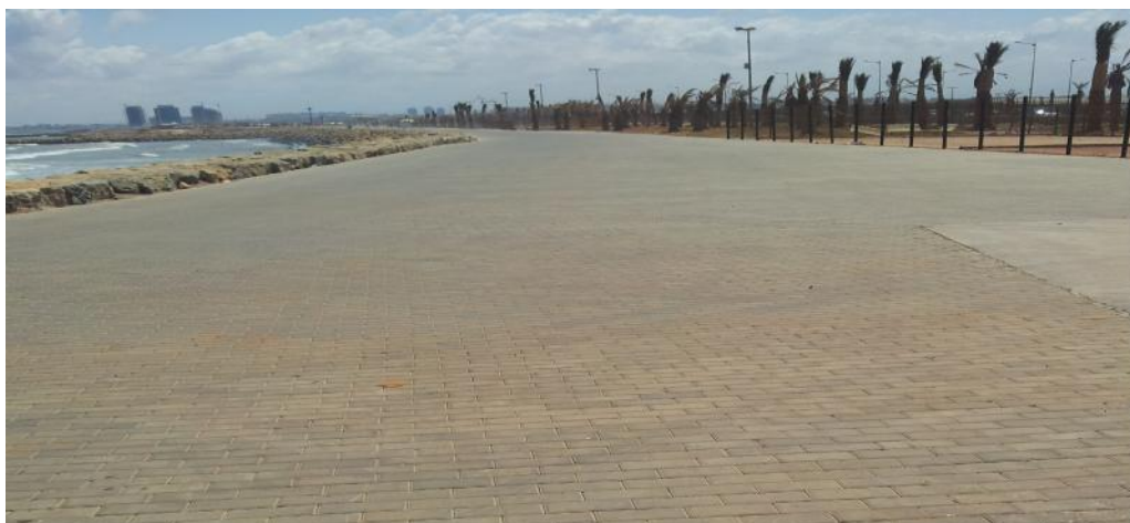
Photo 5 : Allée pour piétons
