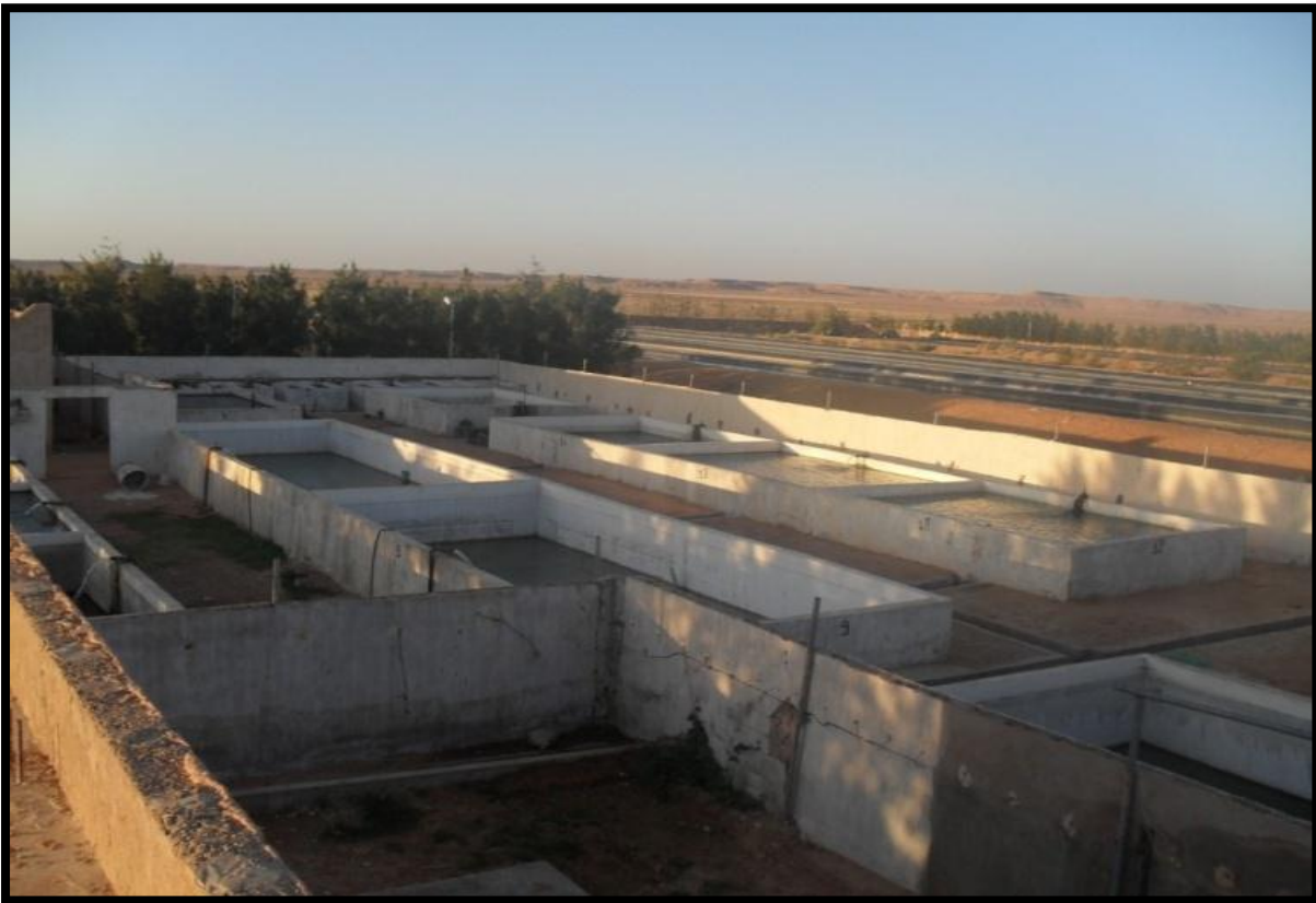
Figure N° 21 : vue générale de l'écloserie.
