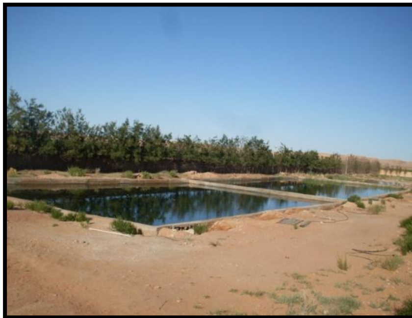
Figure N° 32 : Bassins de décantation.
