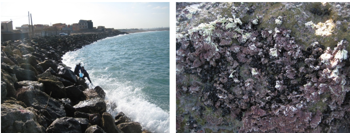
Figure7 : Moulière du bateau cassé sur rochers artificiels
