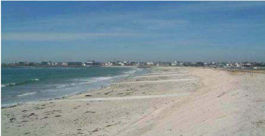
Figure V.9 : Vue des stabiilages transverses sur une plage sableuse
