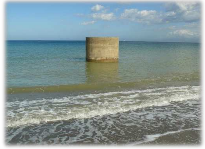
Photo n°25 : Puits d'un terrain agricole submergé par la mer
