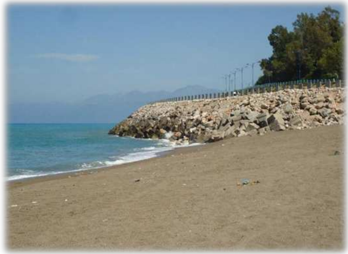
Photo 10 : Falaise développée dans des formations tendres recouvertes par des enrochements artificiels type B.C.R, cas du Cap Tichy.
