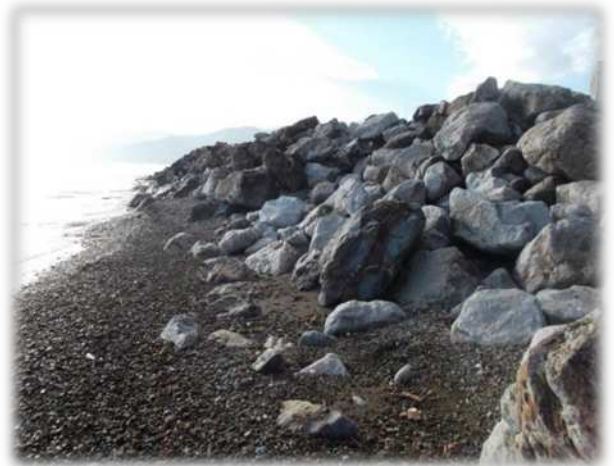
Photo n°02 : Protection en enrochements naturels de la plage de
