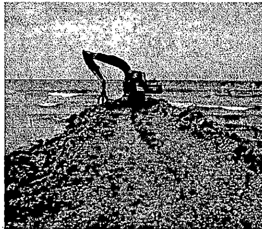
PhotoN°10 : le début de travaux pour la construction du cavalier
