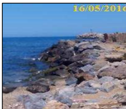
Photo n°21: Photographie présentant la partie Ouest
