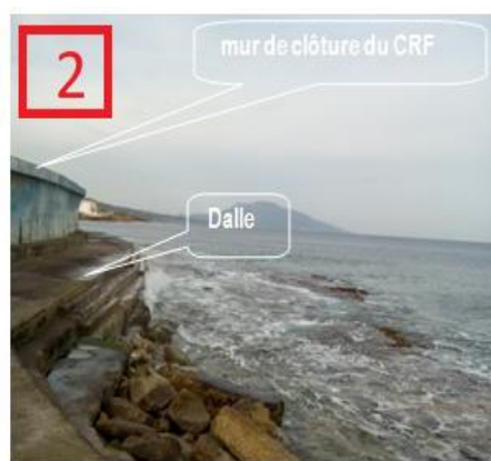
Photo 3 : Mur de clôture et dalle existante à l'arrière du CRF
