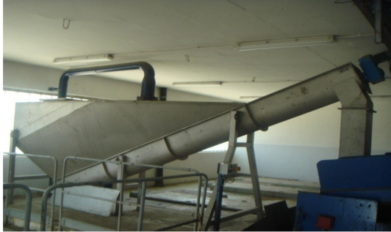
Figure 12: Classificateur à sables
