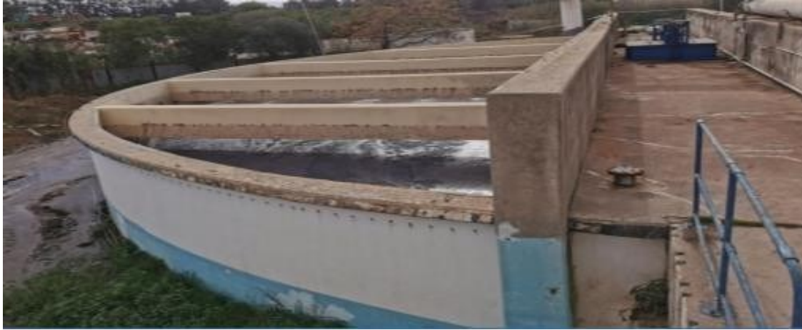
Figure 19.Épaisseurs statiques (photo prise sur terrain avril 2025).
