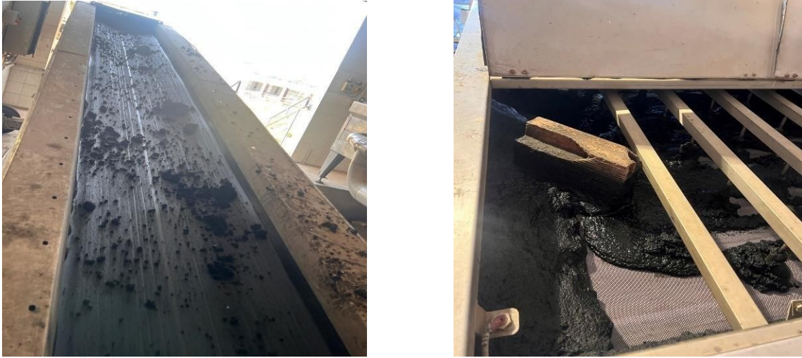
Figure 27. Le filtre a bande de la STEP de Baraki (prise sur terrain 2025).
