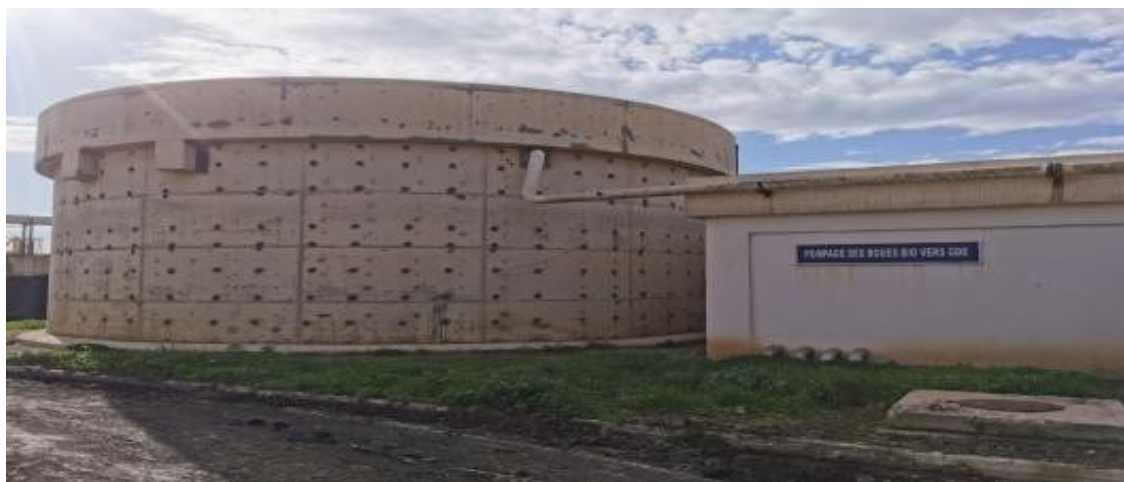
Figure 20. le pré-épaississeur (photo prise sur terrain avril 2025)
