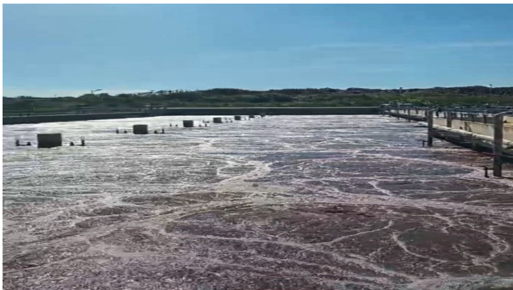
Figure 15. Bassin d'aération (photo prise sur terrain 17 avril 2025)
