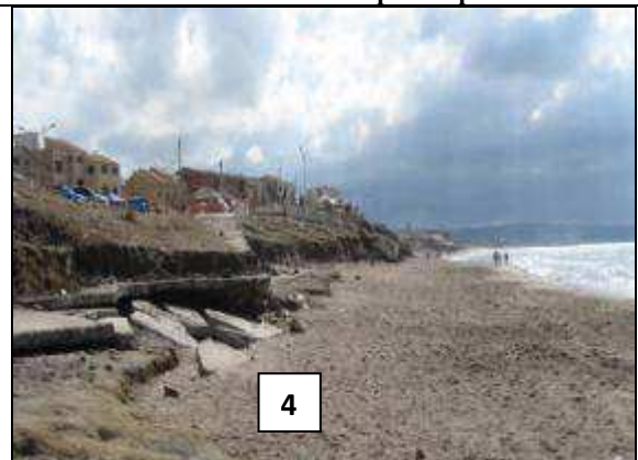
Photo 6 : Erosion et dégâts sur la plage, vue vers l'Ouest.
