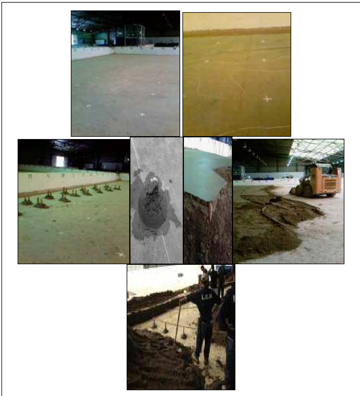
Figure VI.13 : Travaux de construction des fonds bathymétriques dans le bassin à houle, laboratoire du LEM.
