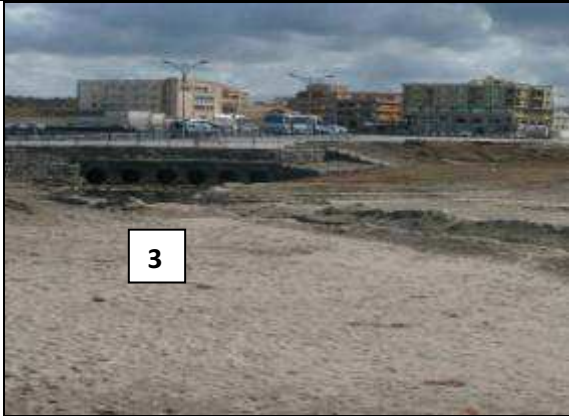
Photo 3 : Débouché de l'Oued.
