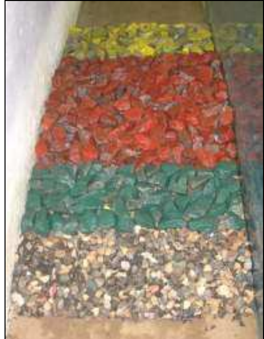
Photo n° 14 : Vue du côté extérieur du brise-lames.
