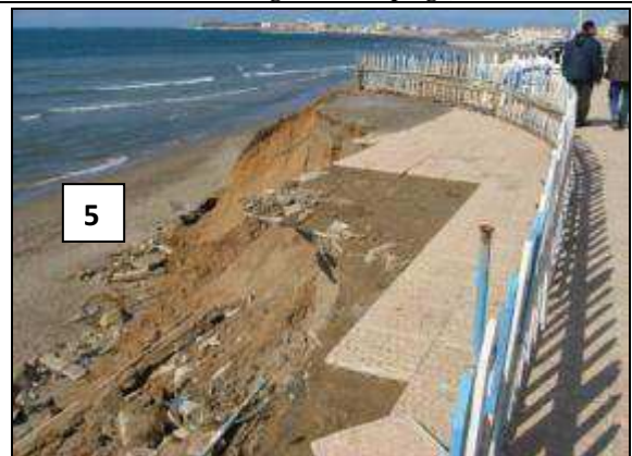
Photo 7 : Erosion de la falaise et éboulements.
