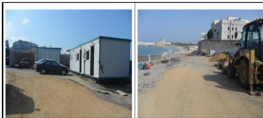
Figure 62 : Installation du chantier
