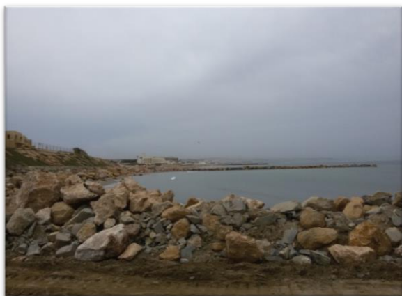
Figure (68) : Travaux pour construction de nouveaux épis au niveau d'Azur.
