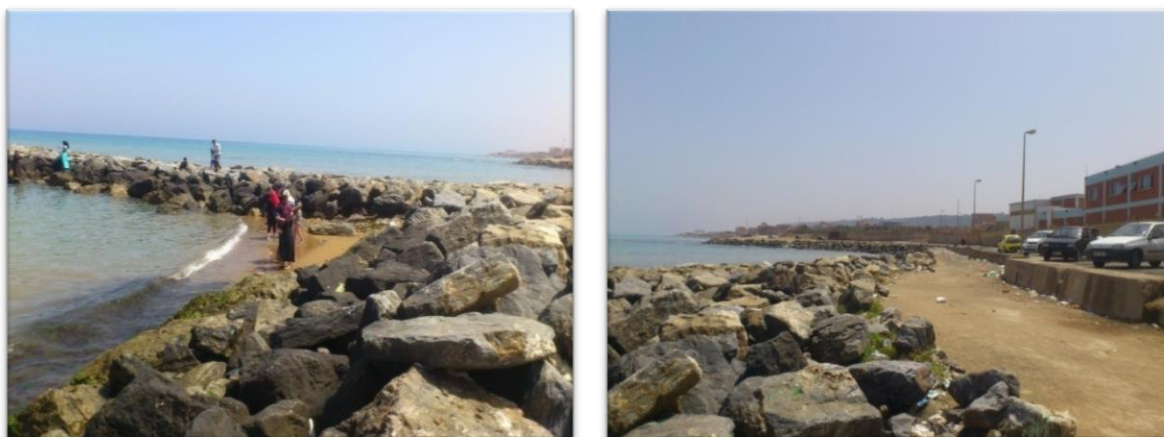
Figure (70) : Ouvrages de protection de Bou-Ismaïl (front de mer).
