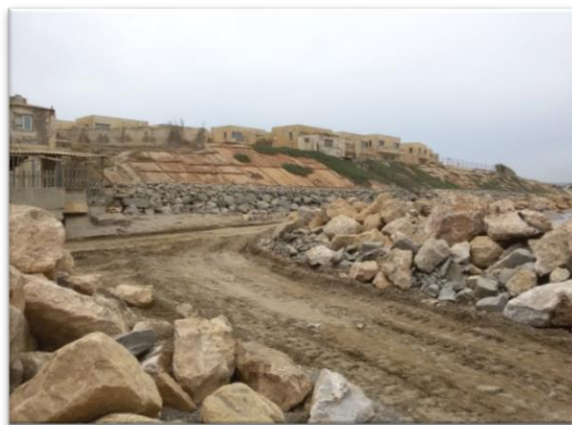
Figure (68) : Travaux pour construction de nouveaux épis au niveau d'Azur.
