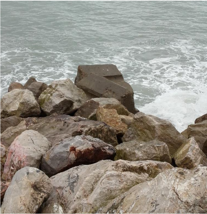
Figure 12: Photos de la protection provisoire installée au bout de piste de l'aéroport de Béjaia
