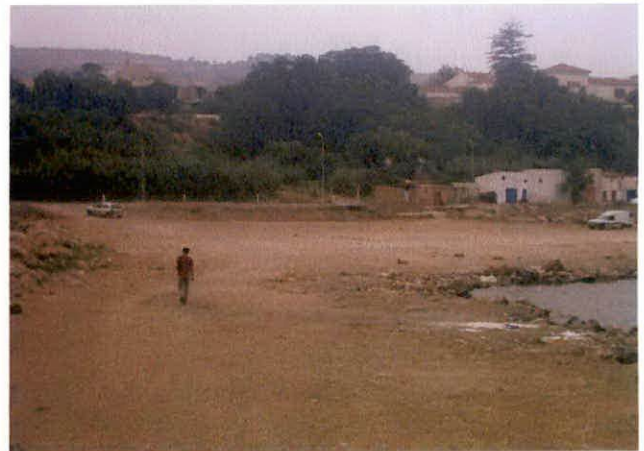
Nouveau quai de réparation
