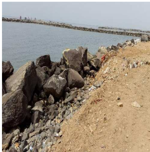
Figure 57 : Les ouvrages de protection de Bou-Ismaïl
