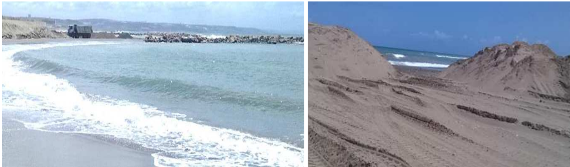
Figure 58 : Les travaux au niveau de Palm Beach
