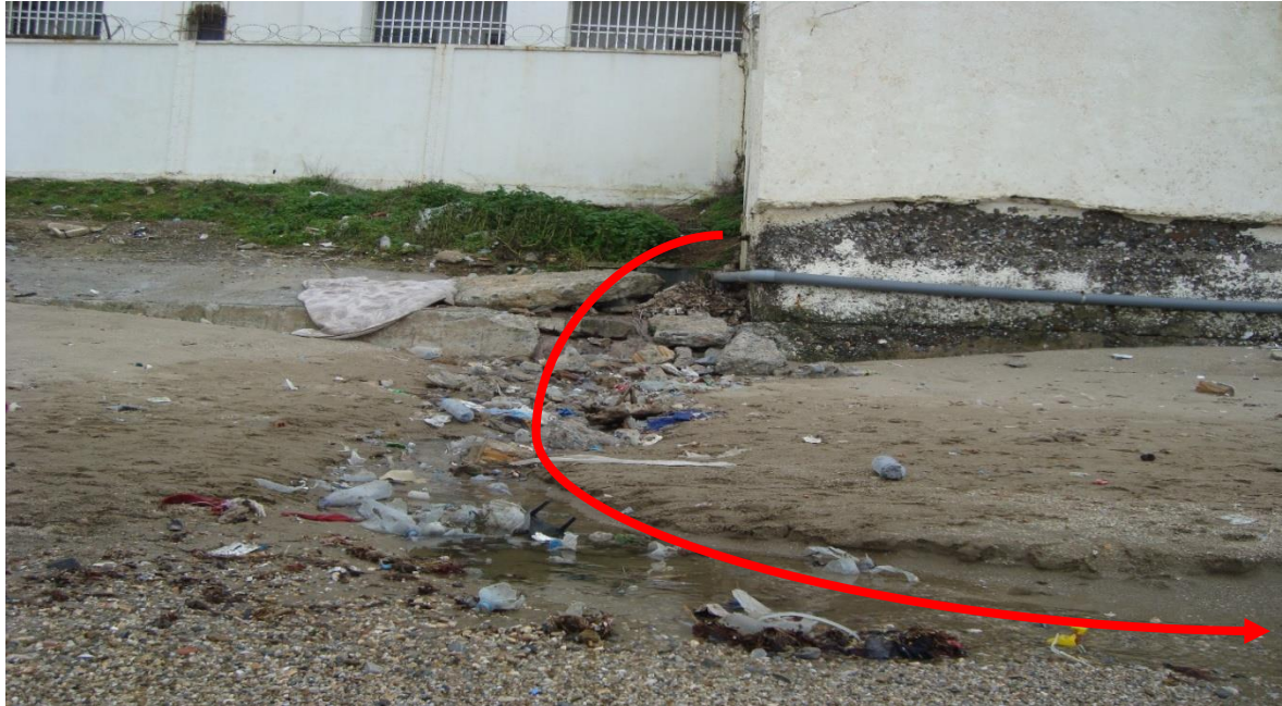
Figure IV-32 : Rejet des eaux usées de l'hôtel El Riadh.
