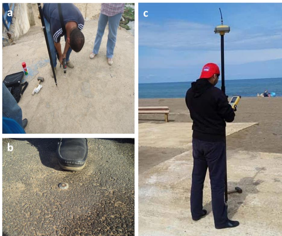
Figure III-9 : Procédé de l'installation d'un point géodésique ; a : plantation du clou, b : clou en place, c : relevé de la série des coordonnées sur le clou.
