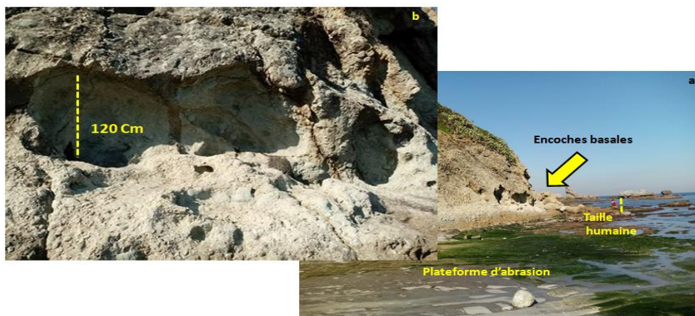
Figure IV-62 : a et b : Encoches basales sur la paroi des falaises de Zerzouria (2018).
