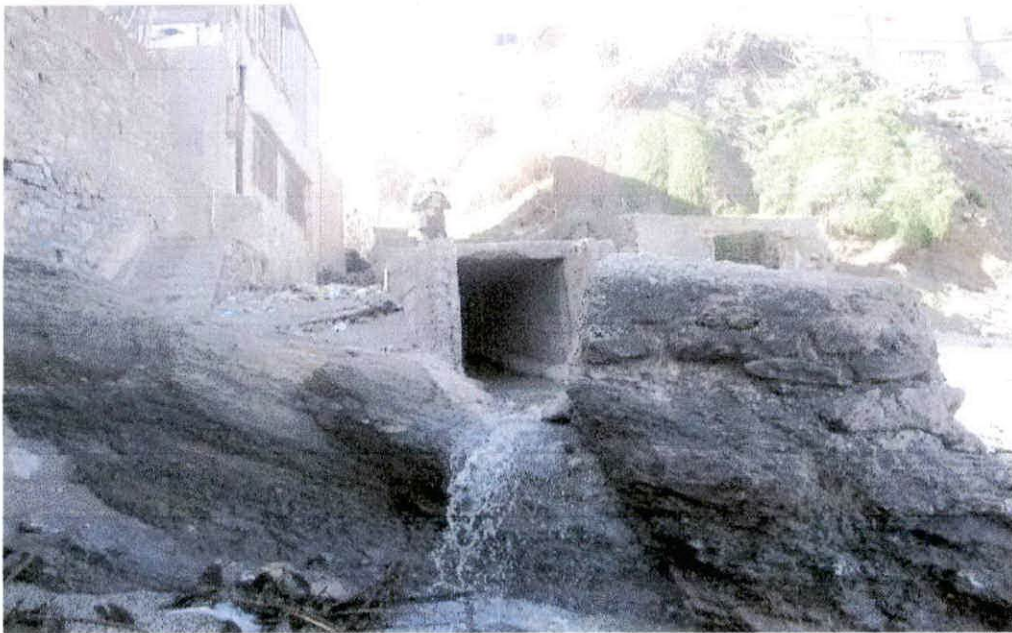
Figure07 : Une vue du rejet et de la plage LAFAYETTE (APPL, 2005).
