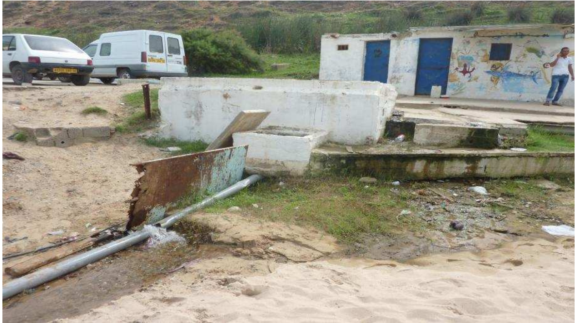
Photo : Rejet au niveau de Réghaia plage (Le16/09/2013)
