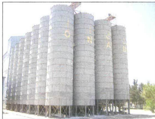
Figure 9 : Silos de stockage des matières premières, O.N.A.B. de Oued Tlelat.
