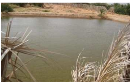
Figure 10 : Réservoir de refroidissement d'eau en terre
