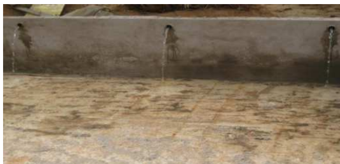
Figure 13 : Entrées d'eau du bassin en dur
