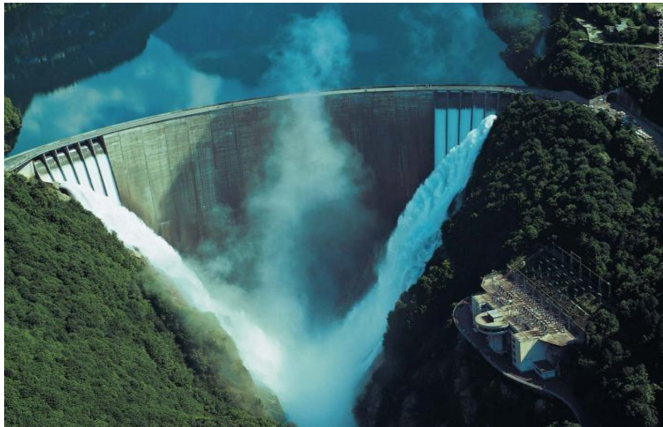
Figure 5. Barrage voûtes contra en Suisse ( www.swissdams.ch/fr )
