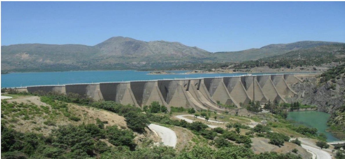
Figure 7. Le barrage hydroélectrique d'Erraguene contrefort, willaya de Jijel (1950)( www.soudoud-dzair.com/ )
