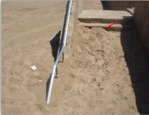
Photo n° 1.5 : Recouvrement des escaliers par le sable.
